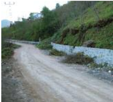
Dereköy mahallesine 720 m. taş duvar
