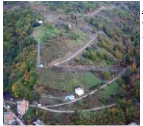
Çam kiriş mahallesine 2200 m yeni yol
