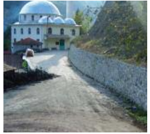
Merkez Camii önünde 200 m 3 'lük taş duvar ve 1000 m 2 kilitli beton parke kaplaması
