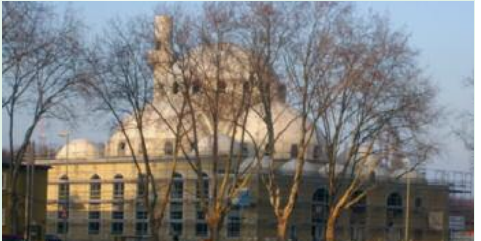
Disburg'taki cami inşaatı
