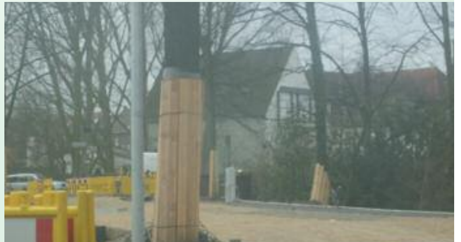
Caddedeki bir inşaat alanında ağaçların gövdelerinin zarar görmemesi için tahtalarla sarılmış... Çevreye ve ağaca verilen önem olağanüstü...
